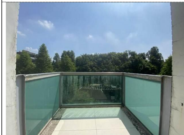
說明：二樓廊道小陽台
