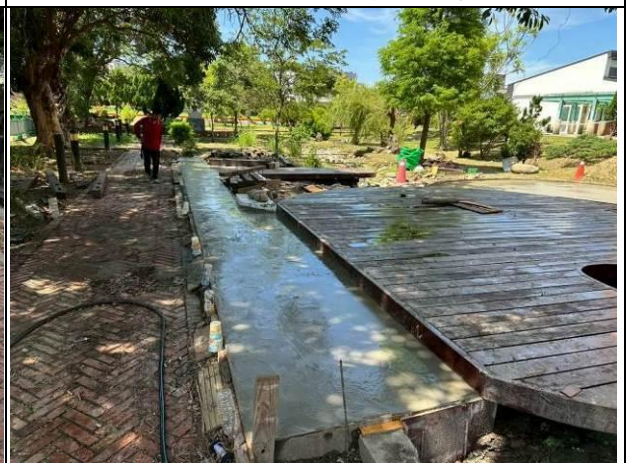
說明：新舊接壤處灌注混凝土
