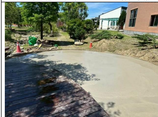
說明：增設紅磚區灌注混凝土
