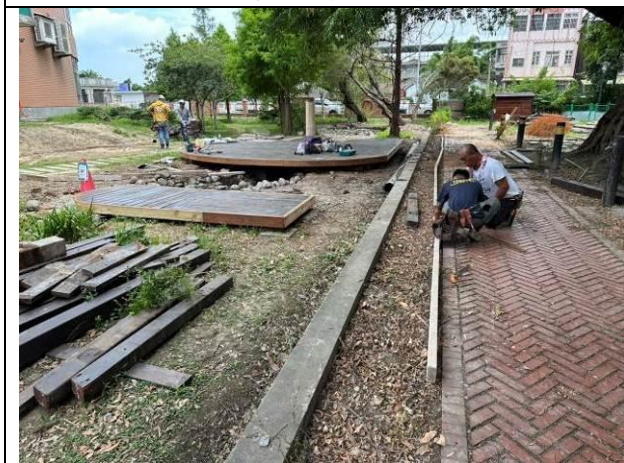
說明：新舊接壤處灌注混凝土放樣與模板
